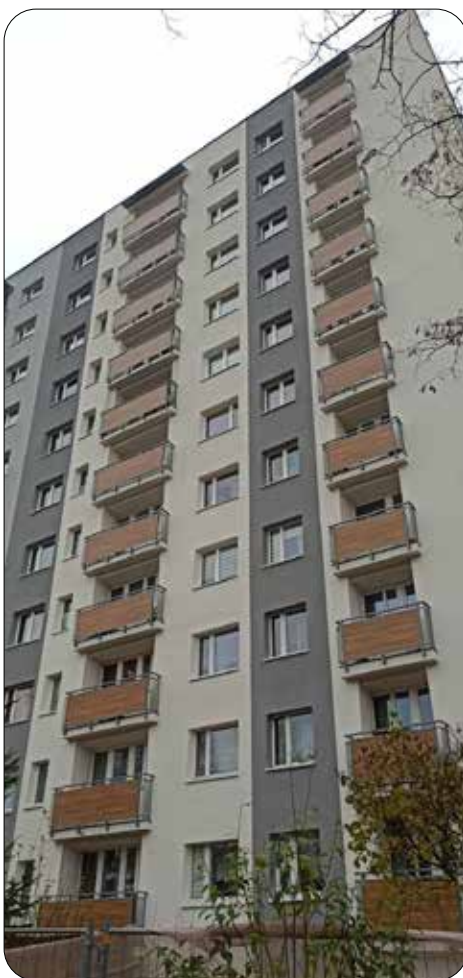
Odnowienie elewacji i remont balkonów przy ul. Ligockiej 70
