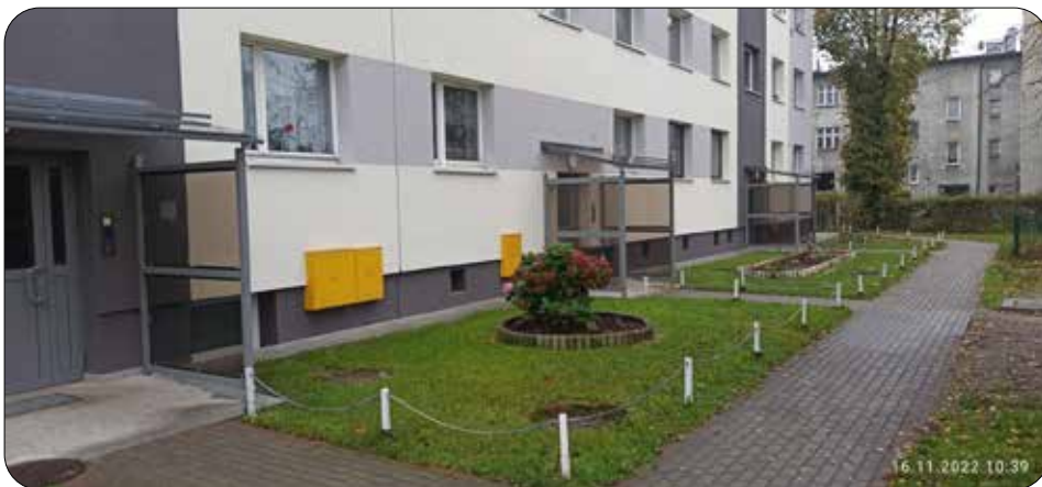
Termomodernizacja budynku przy ul. Armii Krajowej 50A-50C
