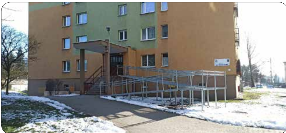
Zmodernizowany podjazd przy ul. Wodospady 6
