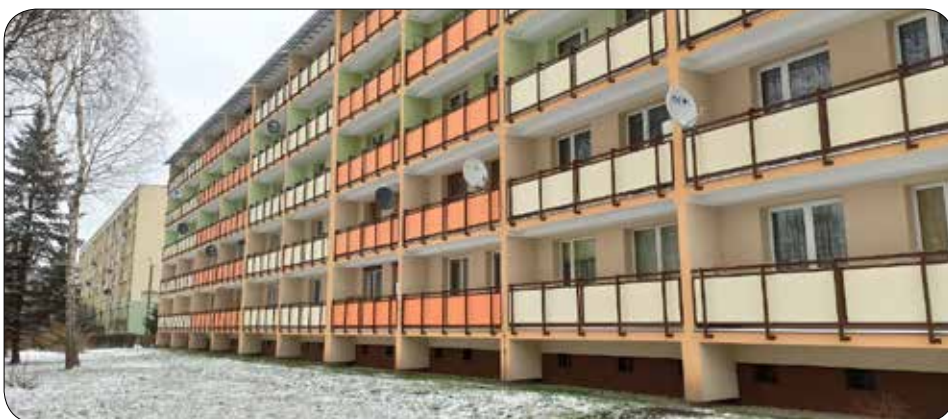
Zakończona została inwestycja termomodernizacji przy ul. Zielonogórskiej 13-21
