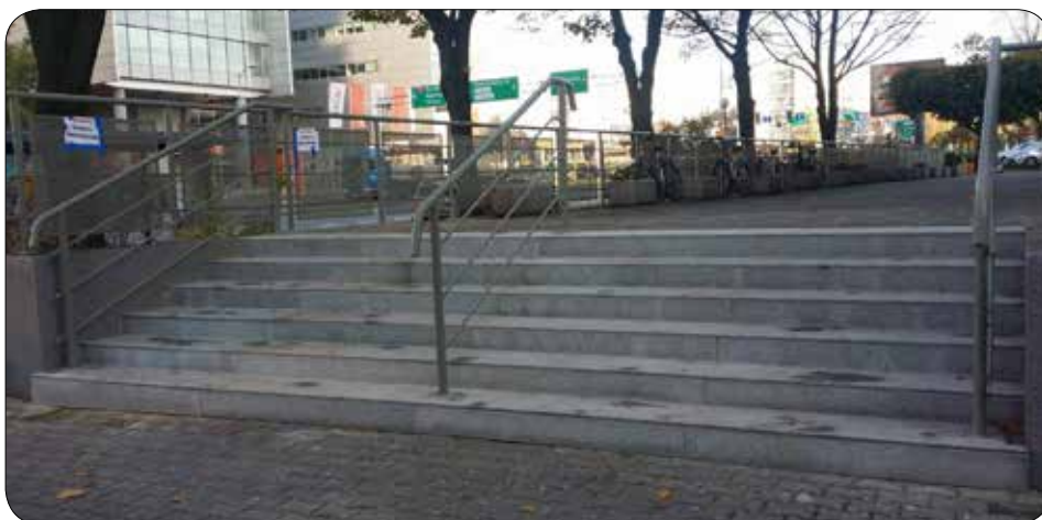
Haperowiec – główne schody po remoncie
