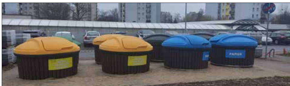
Pojemniki półpodziemne na śmieci zamontowane w rejonie budynków przy ul. Wojciecha 7a-11d
