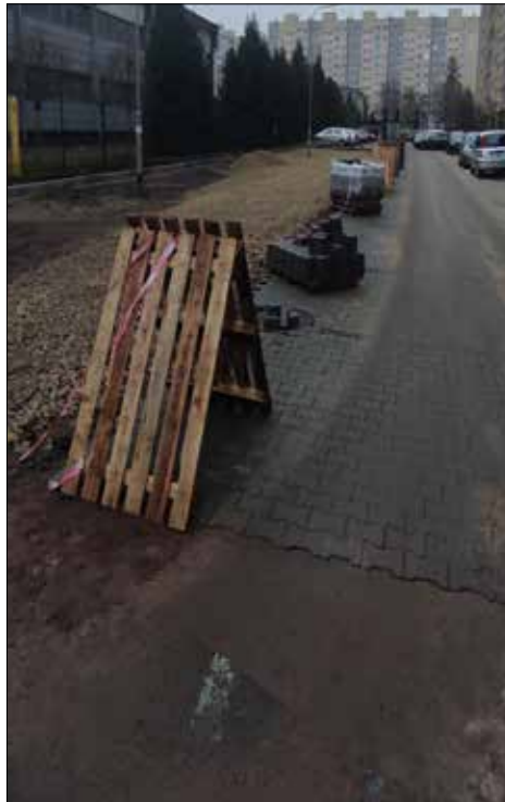
Remont drogi oraz miejsc parkingowych przed budynkiem przy ul. Wojciecha 7a-7h
