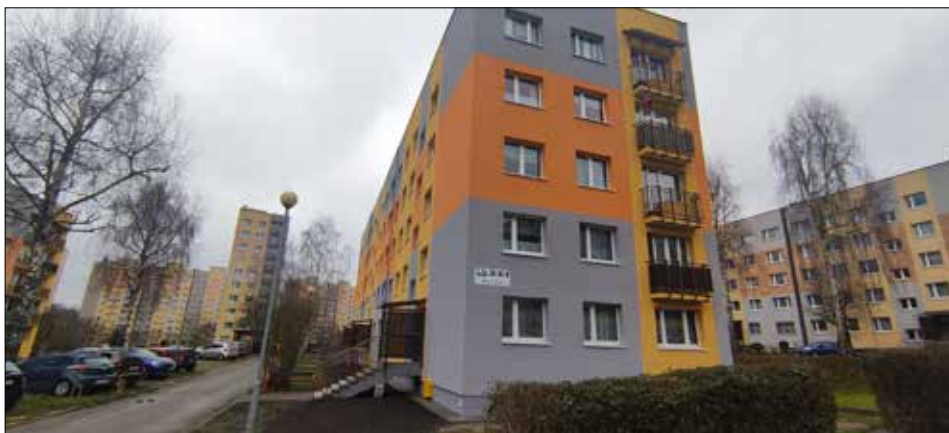
Termomodernizacja budynku przy ul. Wojciecha 35-35b
